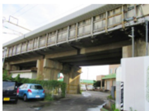
(4) 高架下を潜り抜けます。
